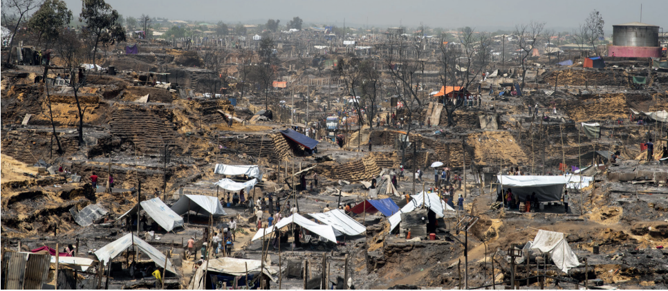
Bangladeş Cox's Bazar bölgesi Kutupalong yerleşkesinde yanıcı malzeme ile yoğun yapılaşma yangına sebep olmuştur, Bangladeş, Mart 2021. Kaynak: GSC Shelter Projects, s.93
