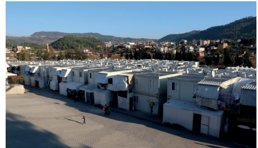
Hatay Yayladağı Geçici Barınma Merkezi, süreç içerisinde dönüşüm geçiren konteynerler, yapılan eklemeler, 2019 Kaynak: TRT Haber
