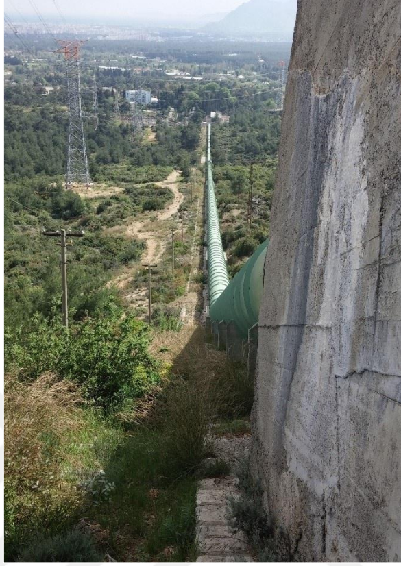
Şekil 2.5: Cebri boru güzergâhı [39].
