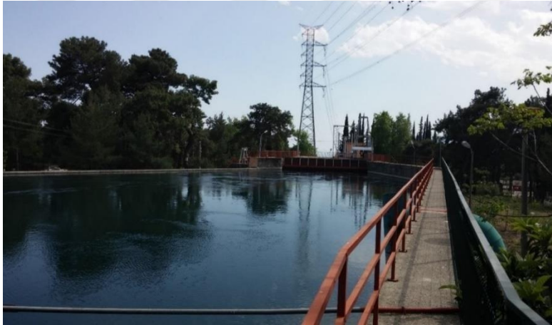
Şekil 2.4: Enerji tüneli su alma yapısı ve havuzun membadan görünümü [39].
