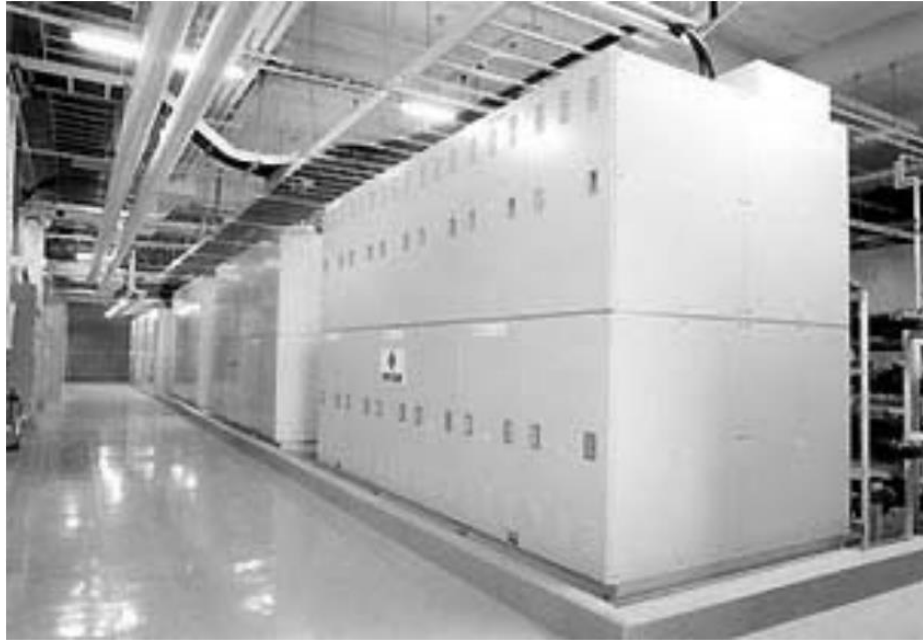
Şekil 2.24 : 1.5 MW'lık vanadyum redoks akış bataryası (Lotspeich, 2002).
