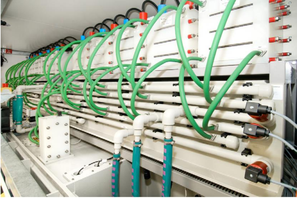
Şekil 2.27 : Cellcube FB10/100 vanadyum redoks akış bataryası akış kanalları ve güç yığımları (Schreiber, 2012).
