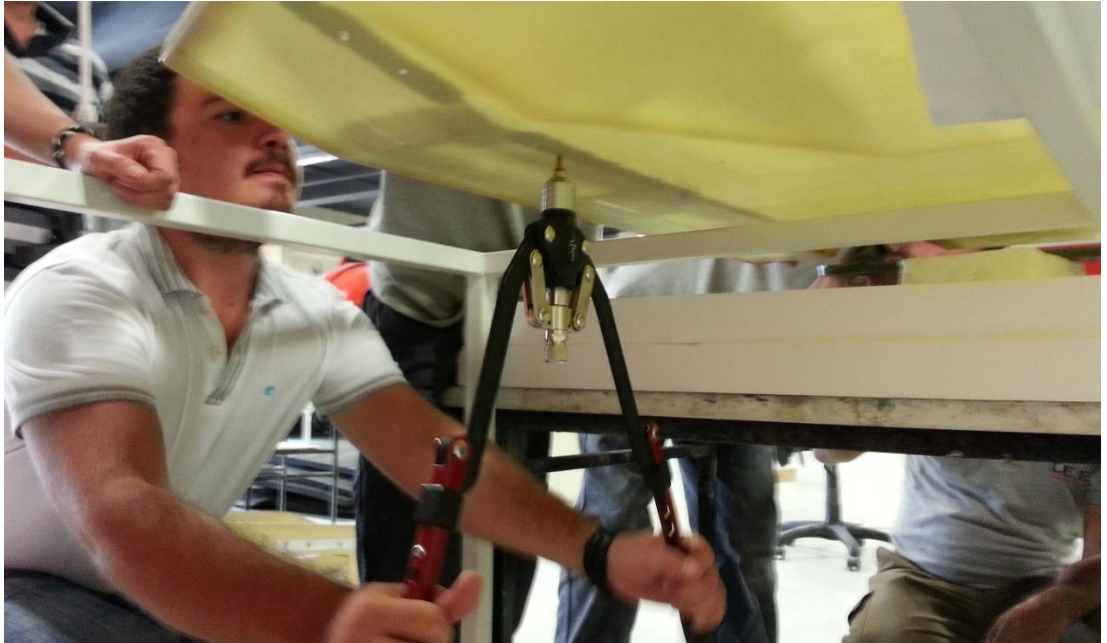
Şekil 4.12. Kompozit kabuk ile alüminyum kaburganın perçinlenmesi.
